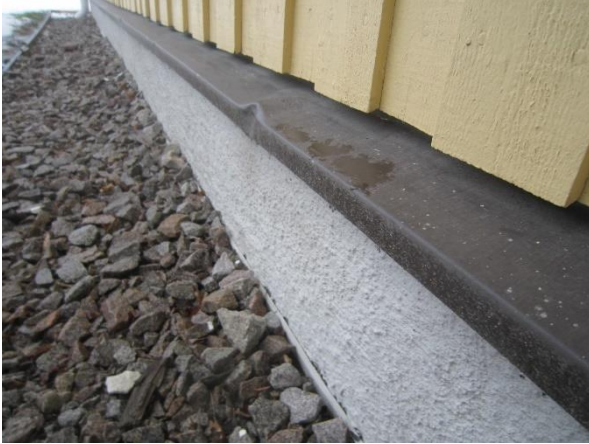
Kuva 3: Sokkeliin on asennettu perusmuurilevy.
