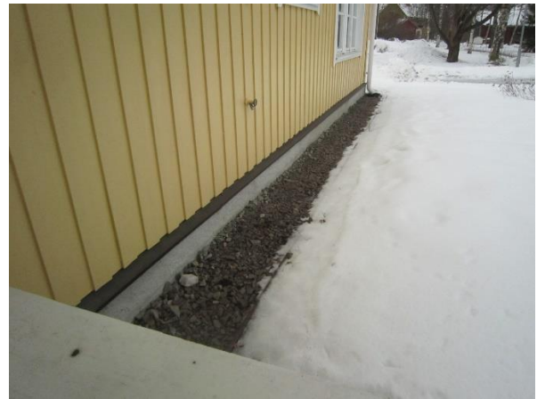
Kuva 2: Slammattu kevytsoraharkkosokkeli ja sepelikaistaa.
